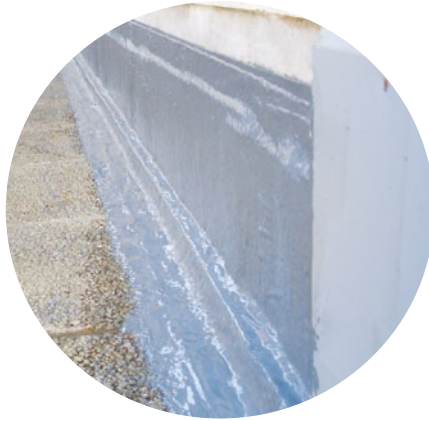
Seinäliitokset ja piippujen tyvet
